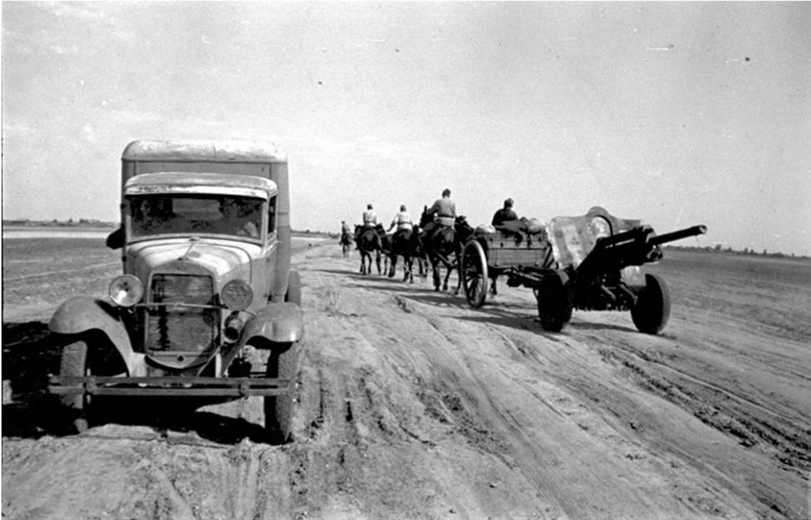
Орудия Ф-22 УСВ с передками перевозятся на конной тяге.
